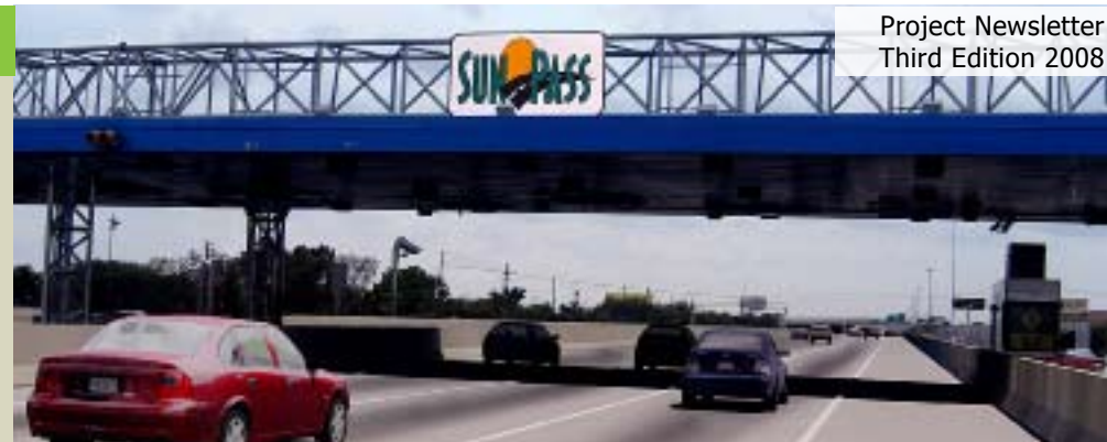
Cypress Creek Open Road Tolling (ORT)
